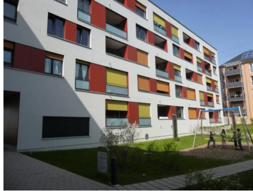
Gebäude zur Hofseite
